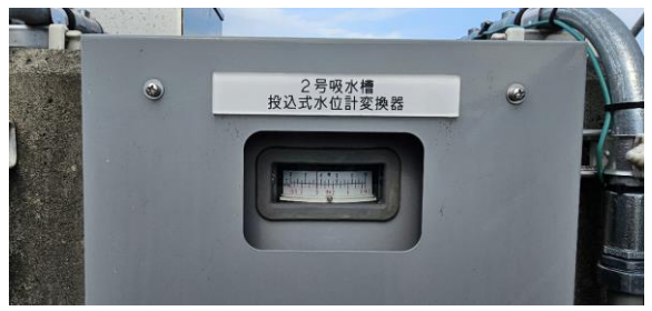
沉砂池水位監測
