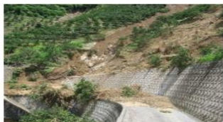
農地崩落及土石堆積在農道 （2018年7月西日本豪雨）
