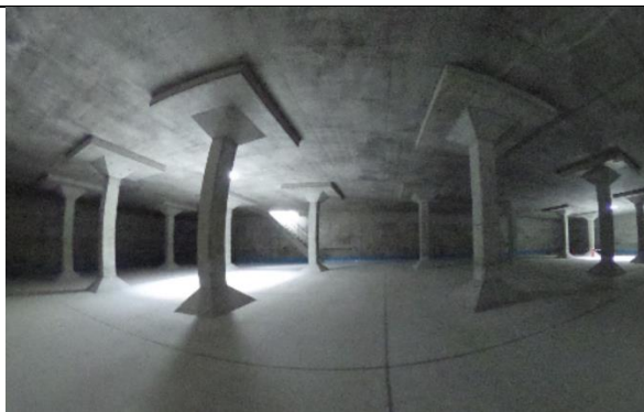
那珂川揚水機場地下調蓄池照片
