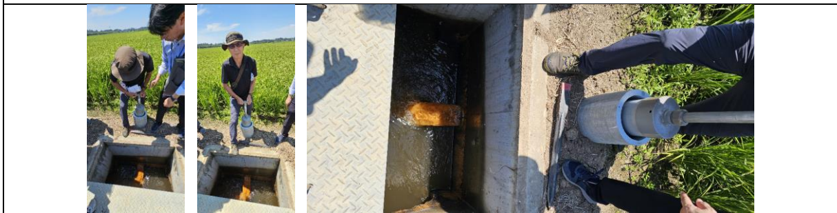
田間排水、制水均採用管路設施，圖為陳處長親自測試操作
