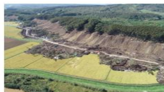
土石流入水田（北海道胆振東部地震） （北海道厚真町）
