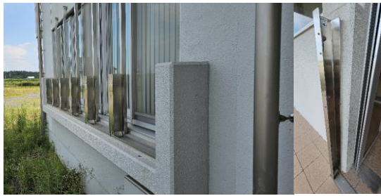
管理所窗戶及大門防水閘板插槽以防止再次淹水致災
