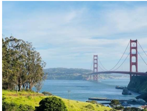
圖 36 金門大橋是舊金山的標誌性地標，也是金門國家遊憩區的一部分
