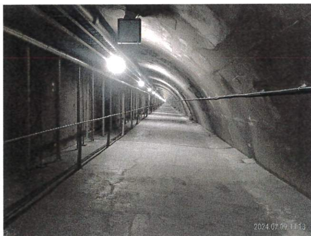
圖 6 檢視阿爾貝格隧道維修通道
