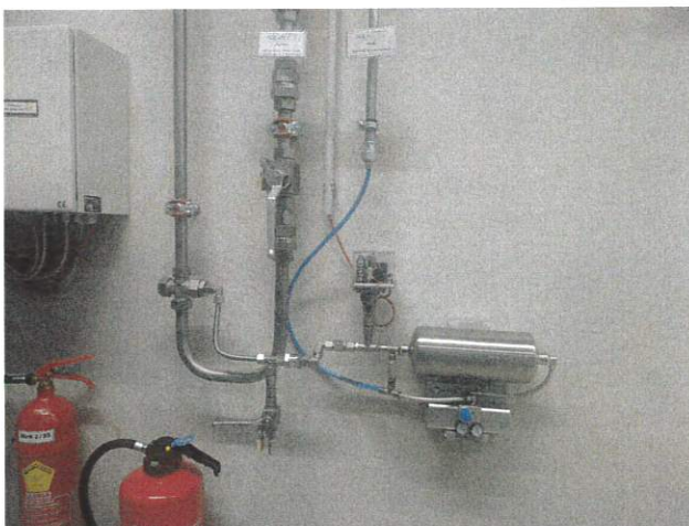
圖 14 水系統末端壓力測試閥
