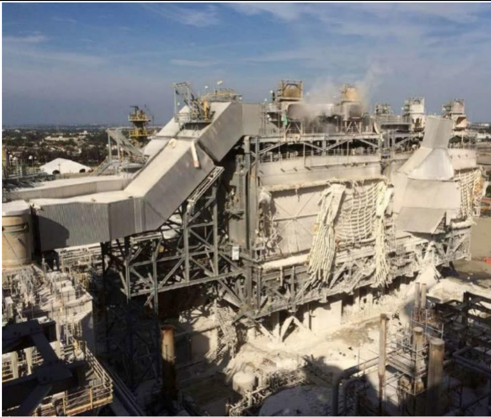
圖 2 ExxonMobil Torrance 煉油廠的靜電集塵器爆炸
