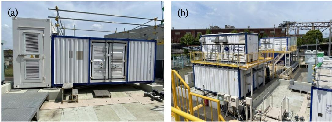
圖九 液流電池試驗場域實景 (a)44 kW 儲能系統;(b)250 kW 儲能系統
