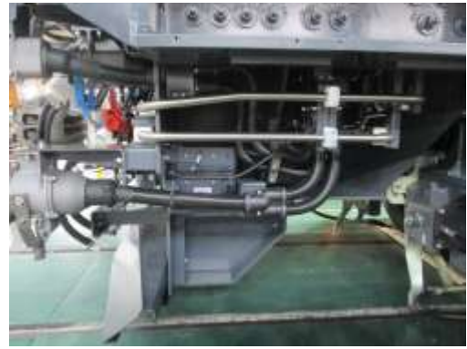
圖 3-54 車下接線安裝
