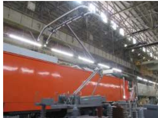
圖 3-68 車頂設備安裝
