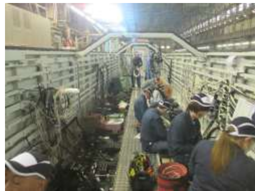
圖 3-62 機械室配線作業
