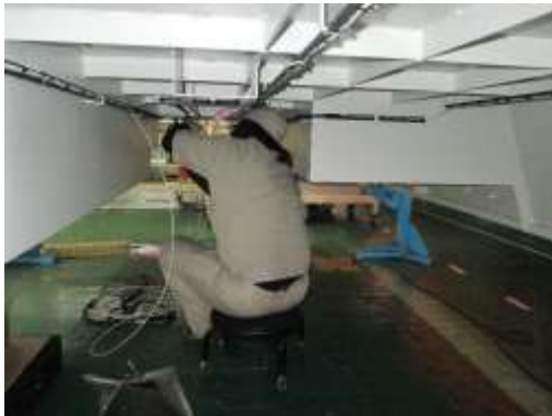
圖 3-67 車頂配線作業
