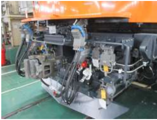
圖 3-53 跨接電纜線安裝
