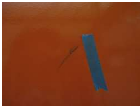
圖 3-6 標記油漆表面輕微瑕疵或髒汙待後續處理
