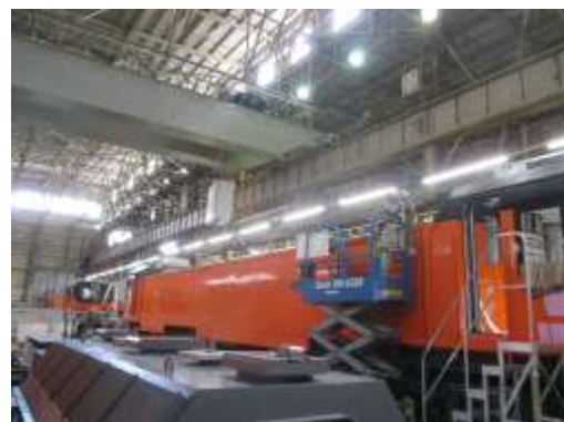
圖 3-64 機械室機器安裝
