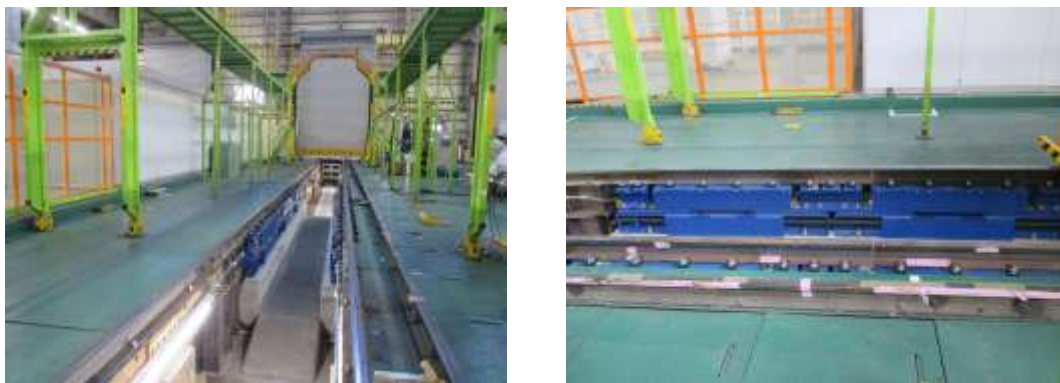
圖 3-10 軸重量測設備
