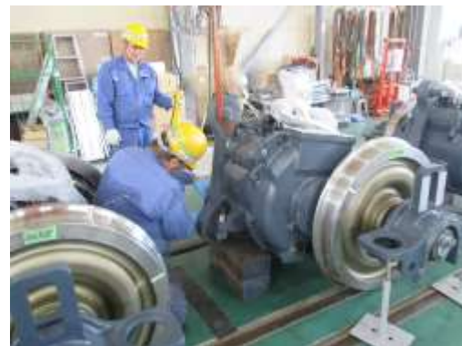
圖 3-72 馬達懸吊支架安裝
