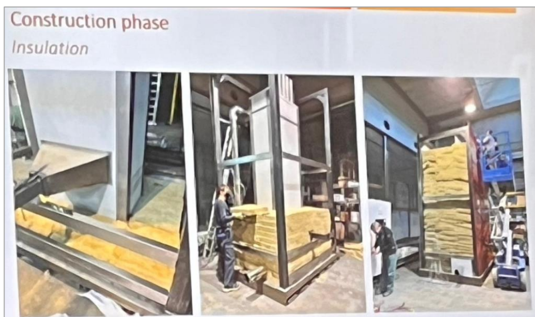
圖 22 HSB 儲熱系統建造階段
