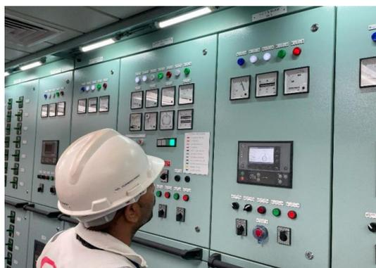
5. IGG系統啟動操作測試：含氧量設定值於3.5%時可穩定作業，管壓功能皆正常。
