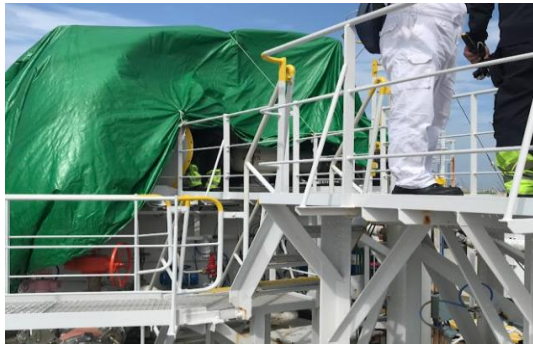
儲槽頂部入口與蓋上之帆布
