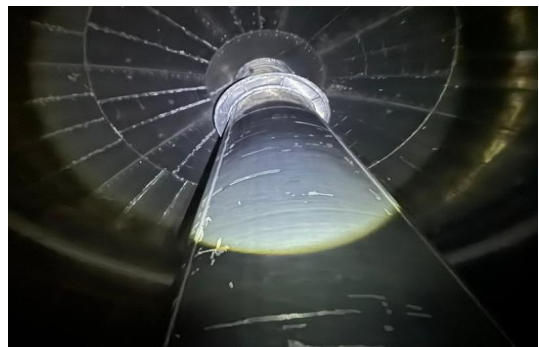
泵井照片(船方提供)
