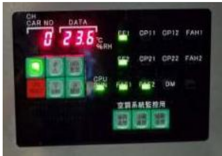
圖 152 空調控制器的顯示設定單元
