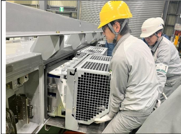
圖 38 元件拆卸組裝示範
