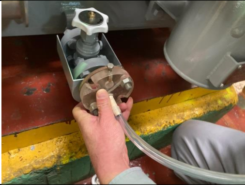
圖 52 主變壓器卸油示範
