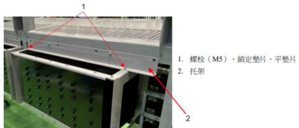
圖 116 移除整流器單元 2 的螺栓
