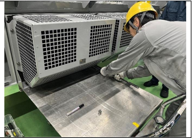
圖 37 元件拆卸組裝示範
