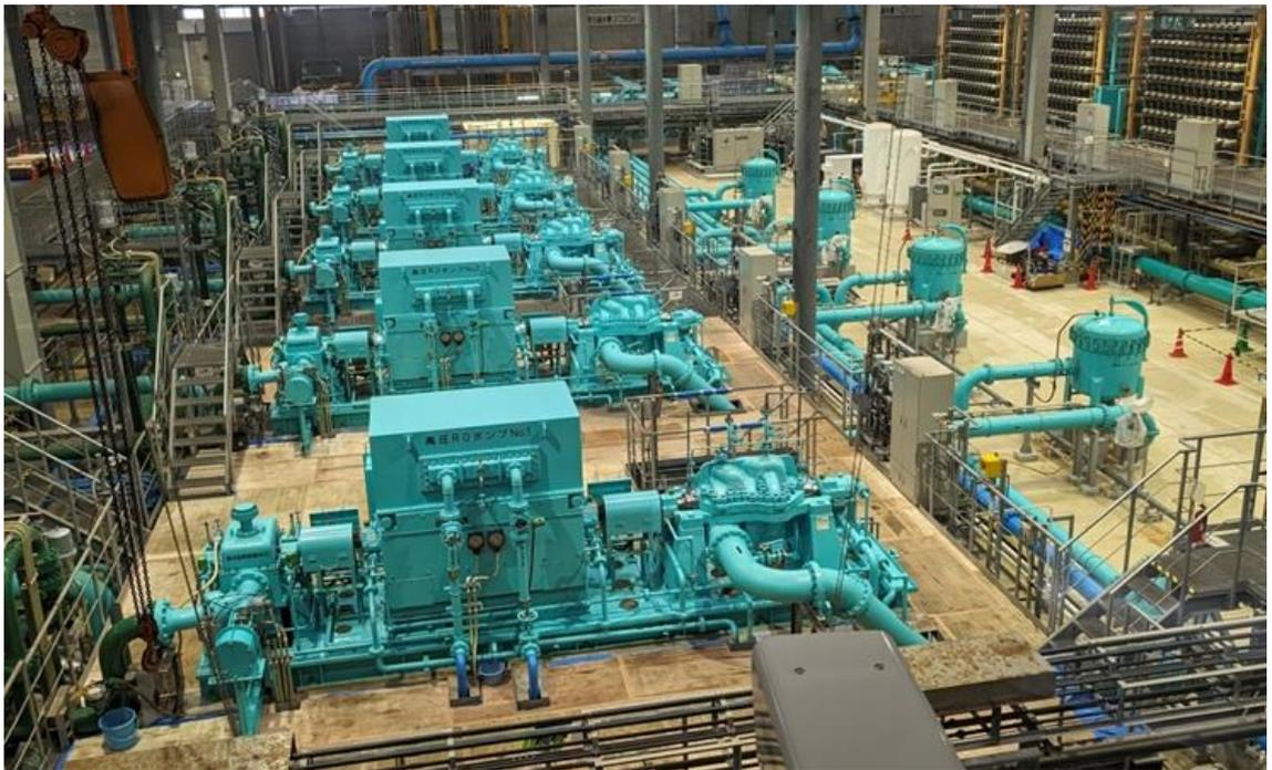
圖 3.3.11 保安過濾器、RO 高壓泵及能源回收裝置
