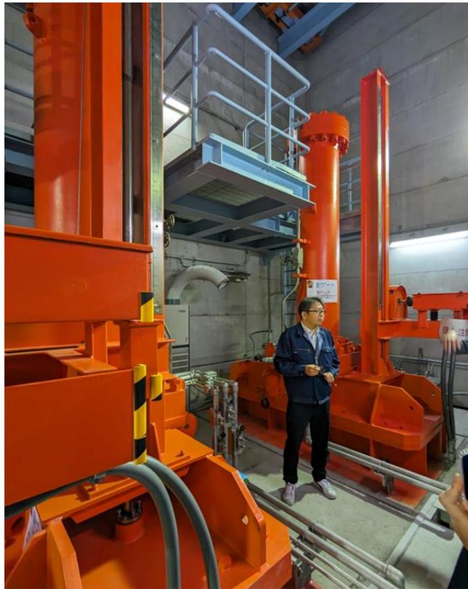
圖 65 高位常用洪水油壓閘門操作室
