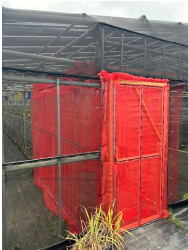
雙重門的防蟲緩衝室
