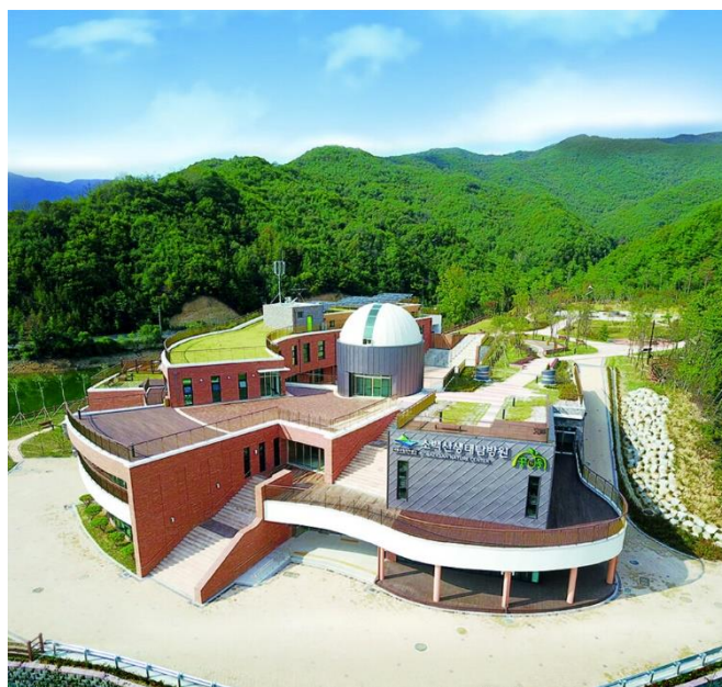
圖 72 小白山探訪院建築
