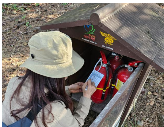
圖 39 滅火器定期檢查工作
