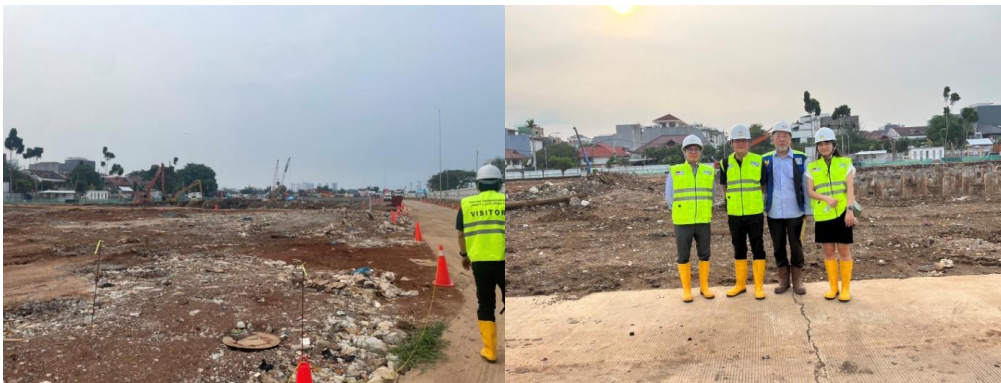
圖 3 訪視中興公司監造之雅加達污水廠工程
