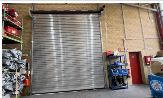
圖 58 倉庫車輛出入口鐵捲門約為 5 米 X5 米，便於大型車輛出入裝載器材。
