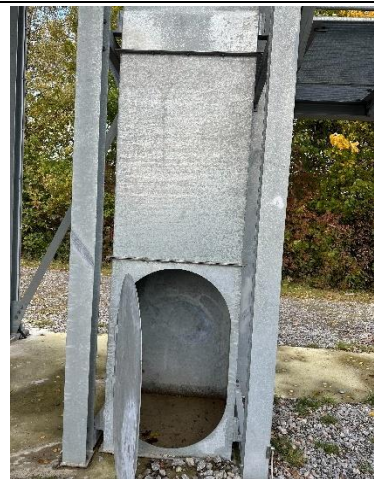
圖 12 訓練高塔中立坑訓練設備
