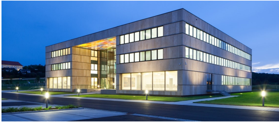
生產區建築物
