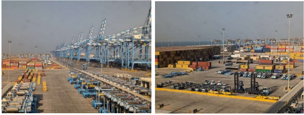
圖 24. 哈里發港現況
