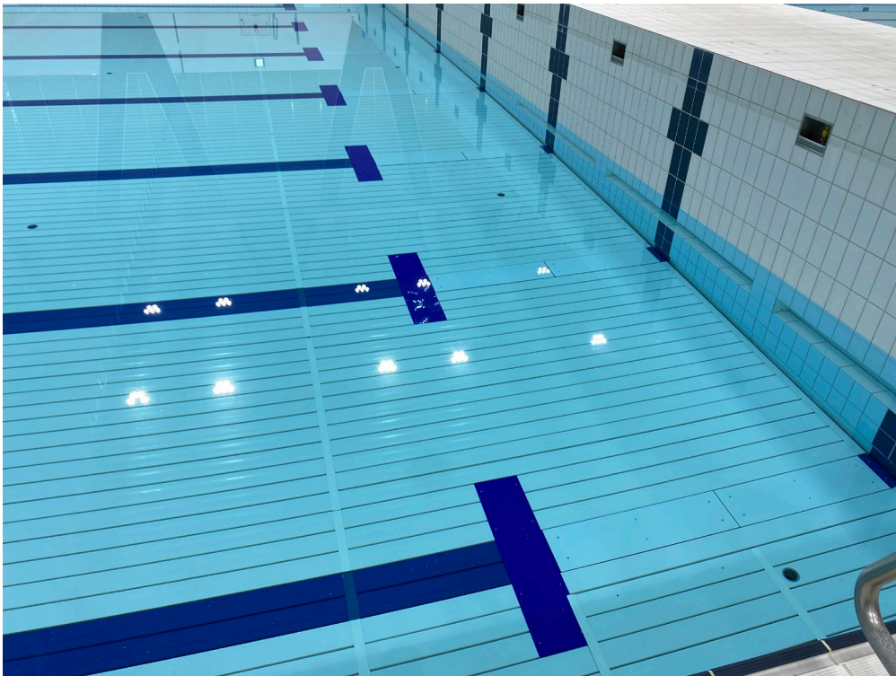
圖 21 副場館游泳池可升降池地板
