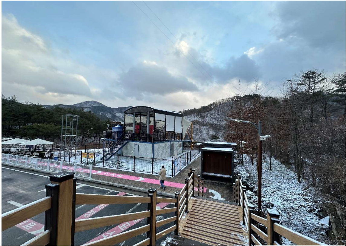
圖 13 (降落區)降落台、員工休息室及停車場全貌
