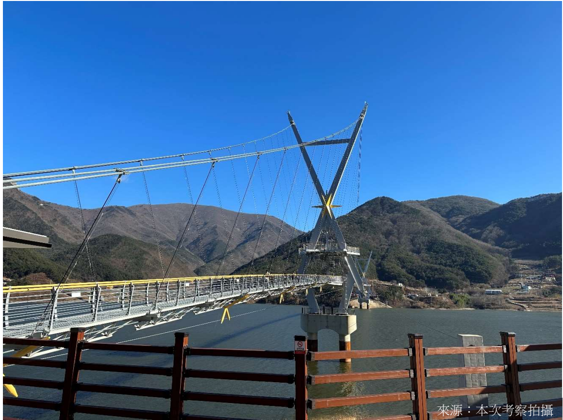
圖 33 (降落區)降落台望向百賢山吊橋
