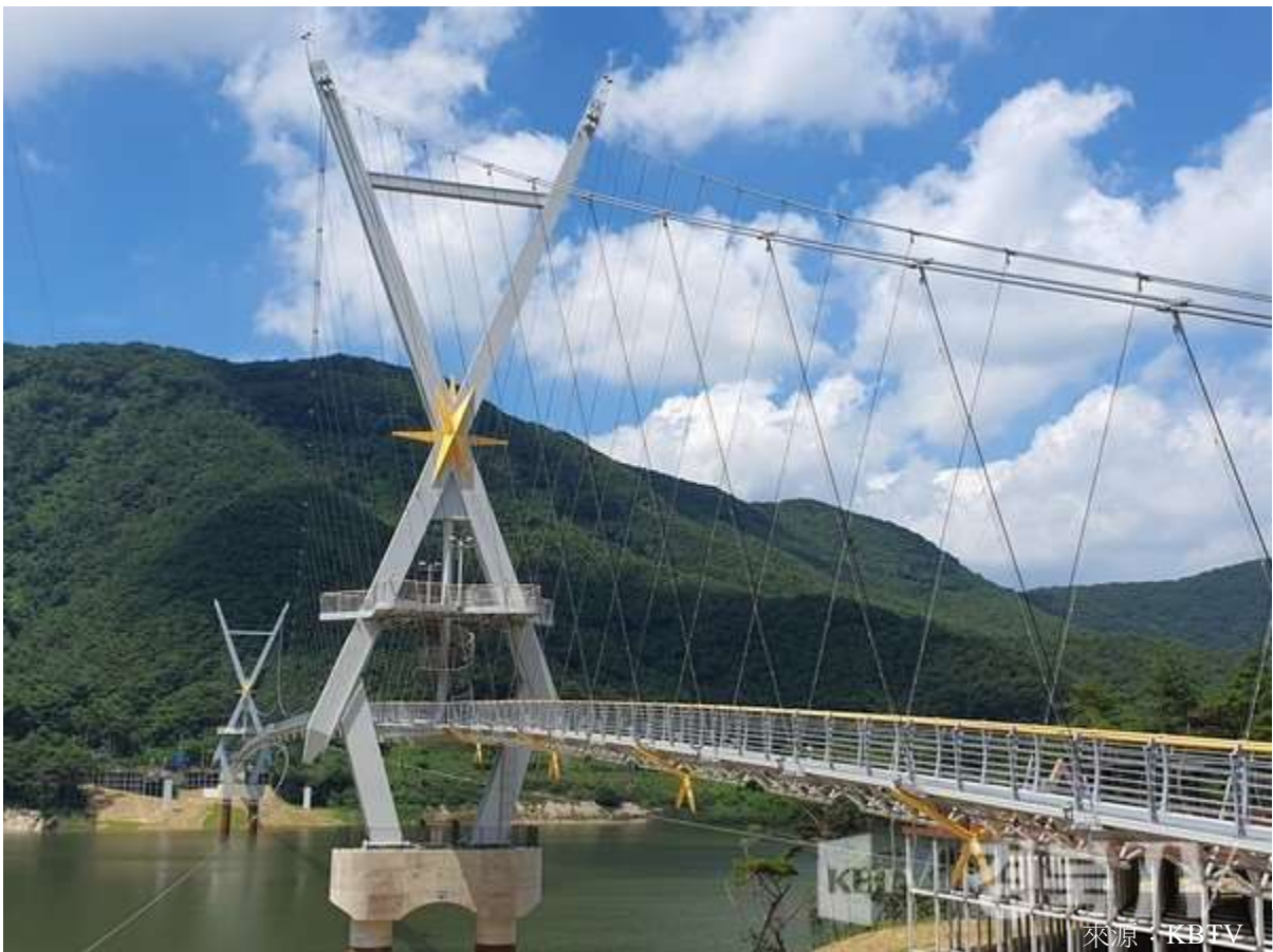
圖 21 永川百賢山水壩吊橋
