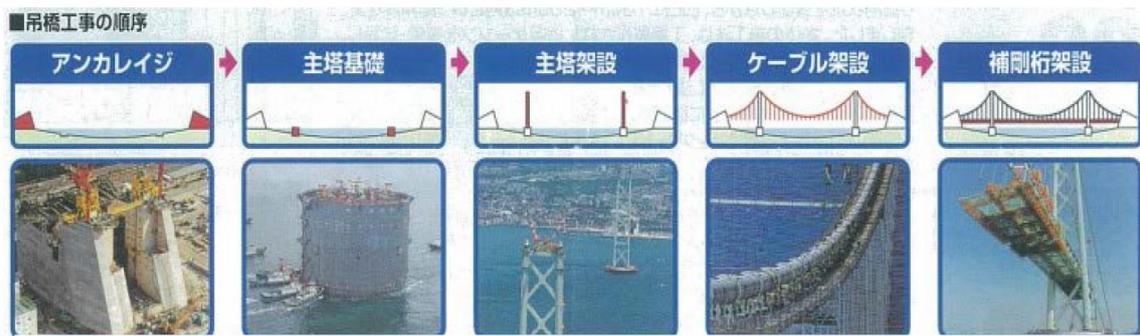
橋台施工 ➡ 橋墩基礎 ➡ 主塔施工 ➡ 鋼纜吊裝 ➡ 橋面施工
