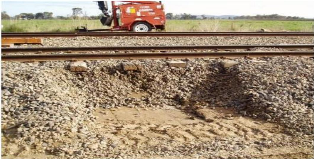
圖 14 檢查軌道道碴橫斷面並確認泥漿污染的程度污染情形
