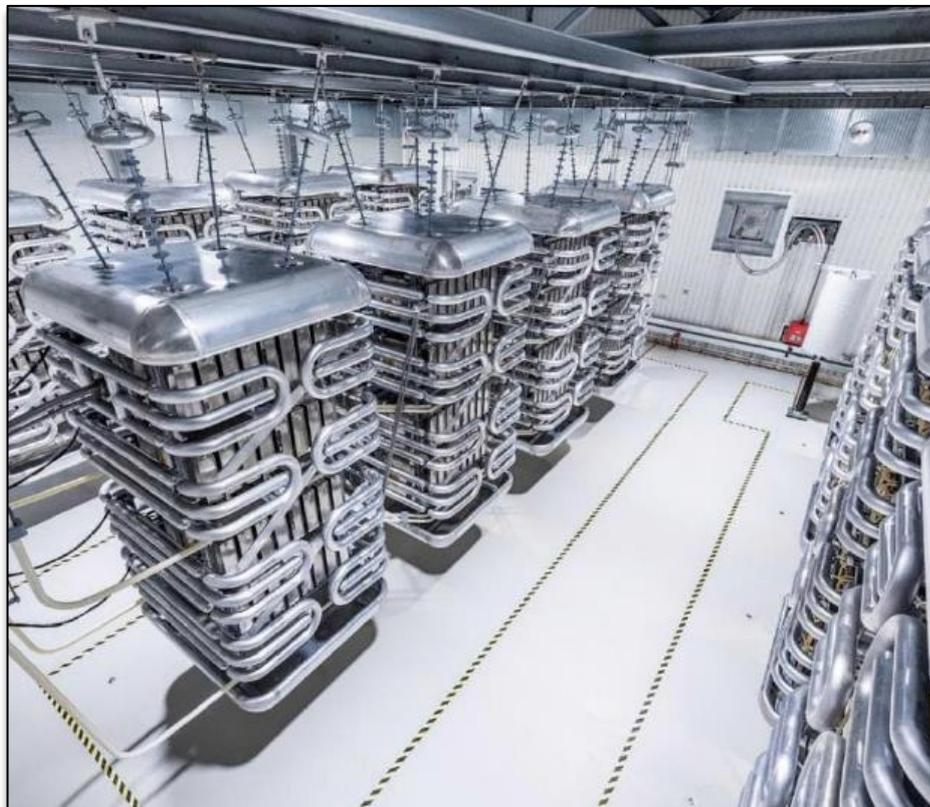
圖 3-11 閥結構組(吊掛式)
