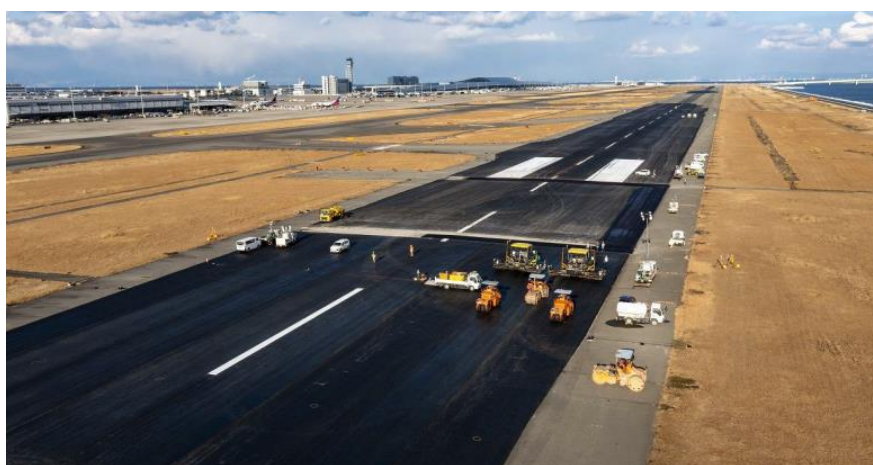
圖 5.10 跑道 A 柔性加舗施工遠景
