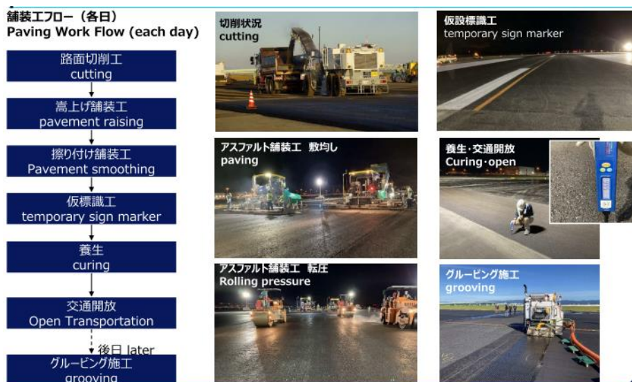
圖 5.9 跑道 A 柔性加舗工序
