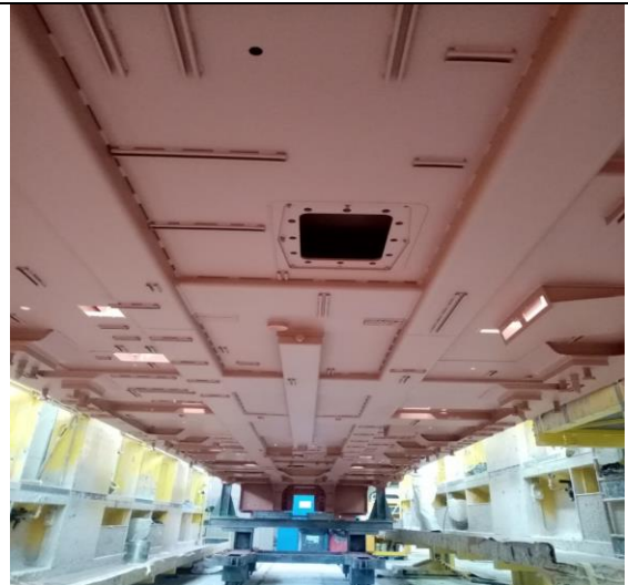
防鏽漆施作工程
