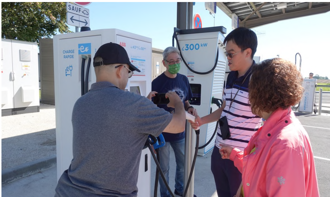
圖 4.15-2 充電樁基礎建設
