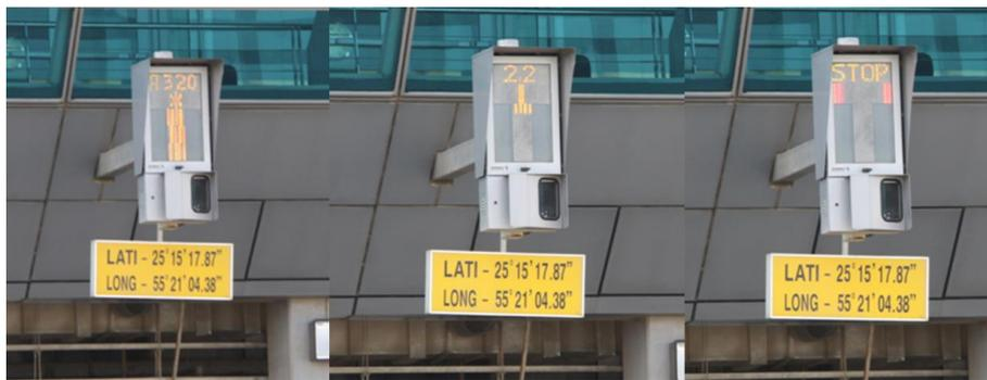
圖 3.3-23 目視停靠導引系統
