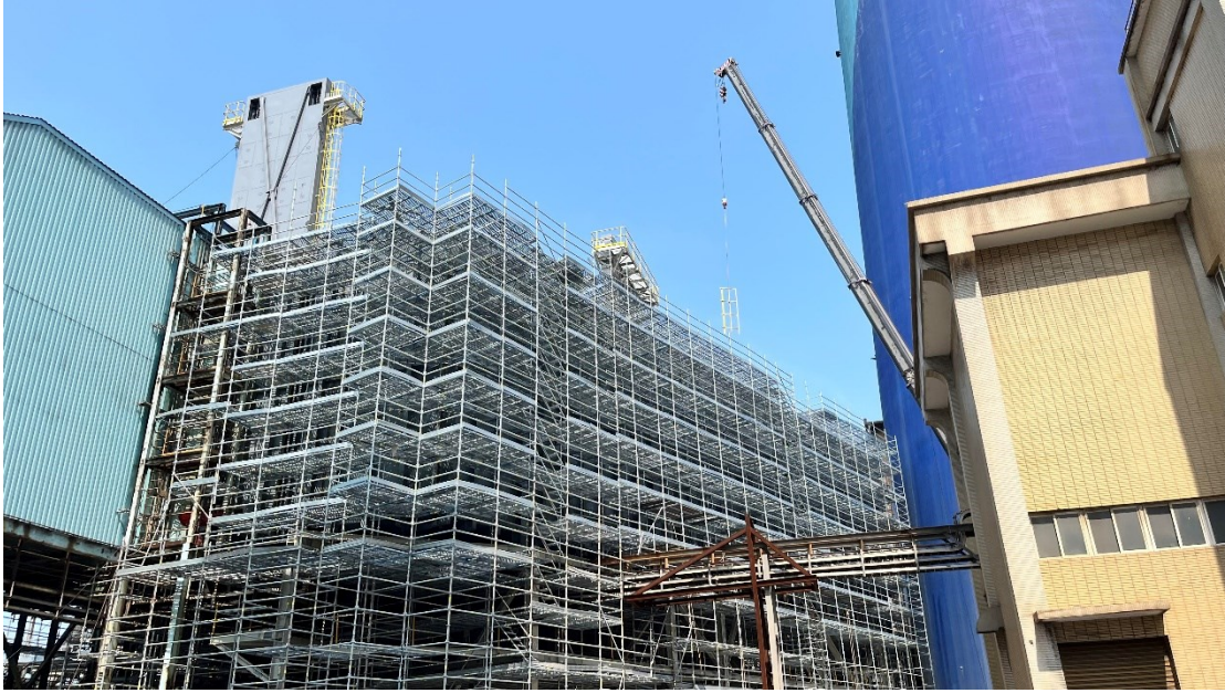
圖 6 - 改善工程現況(MGGH Reheater 區域安裝)
