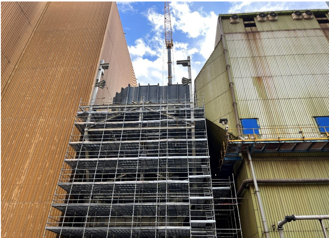
圖 5 - 改善工程現況(MGGH Cooler 區域安裝)
