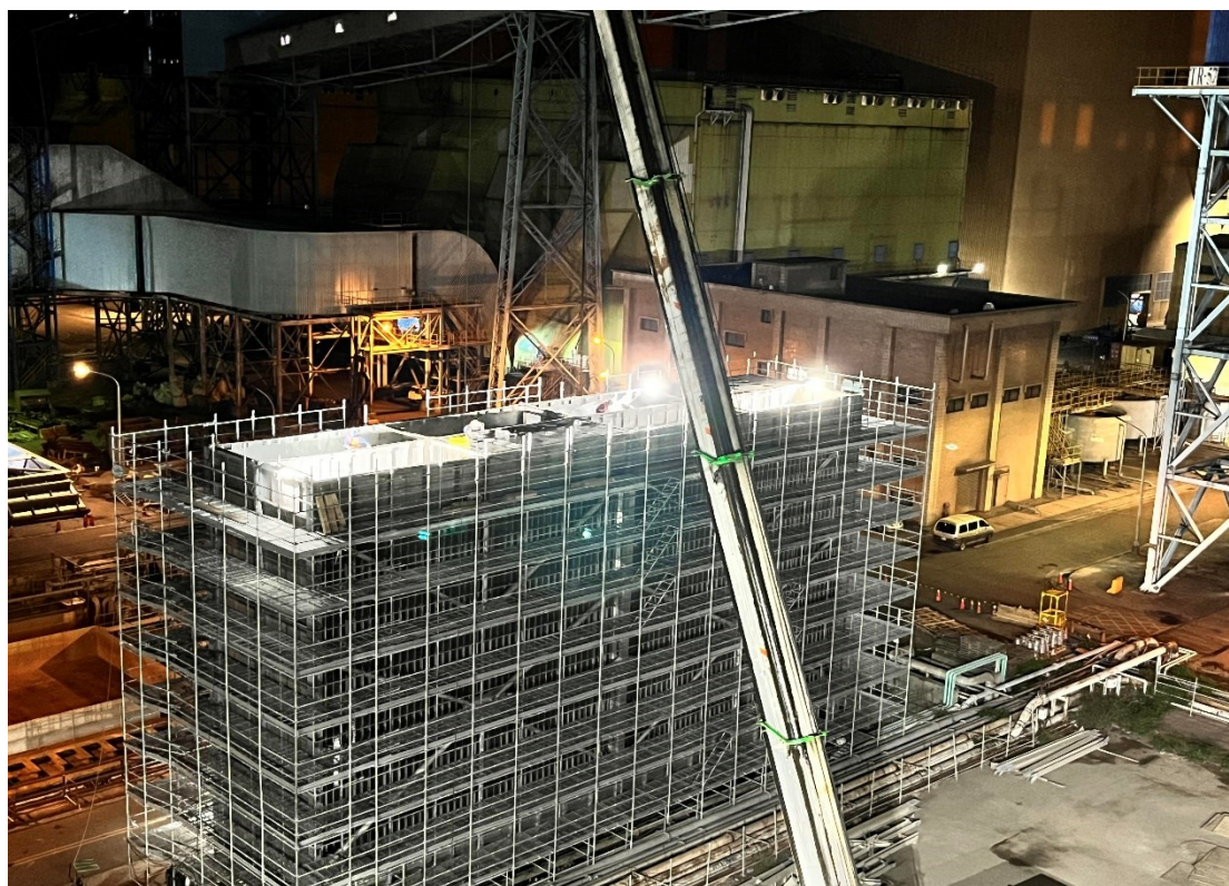
圖 3 - 改善工程現況(WESP 組裝)
