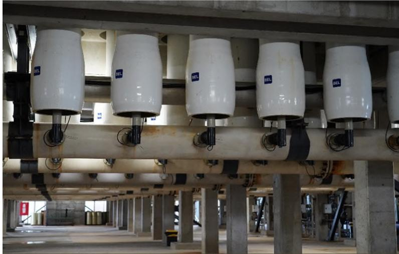
圖 25、廠區逆滲透圓柱設備裝置情形
