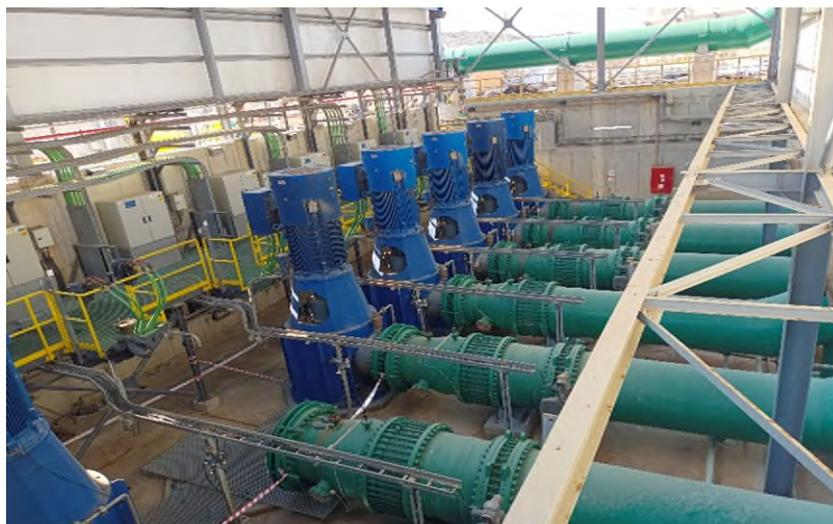
圖 19、Sorek 海淡廠之加壓抽水站配置情形
