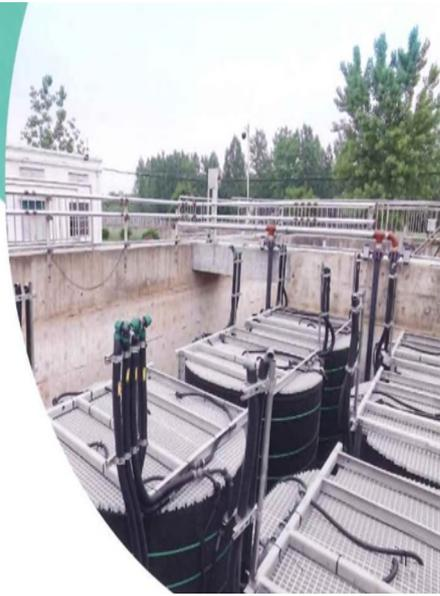
圖 44、安裝於厭氧消化槽中的 SUBRE 模組（資料來源：Fluence 公司提供資料節錄）
