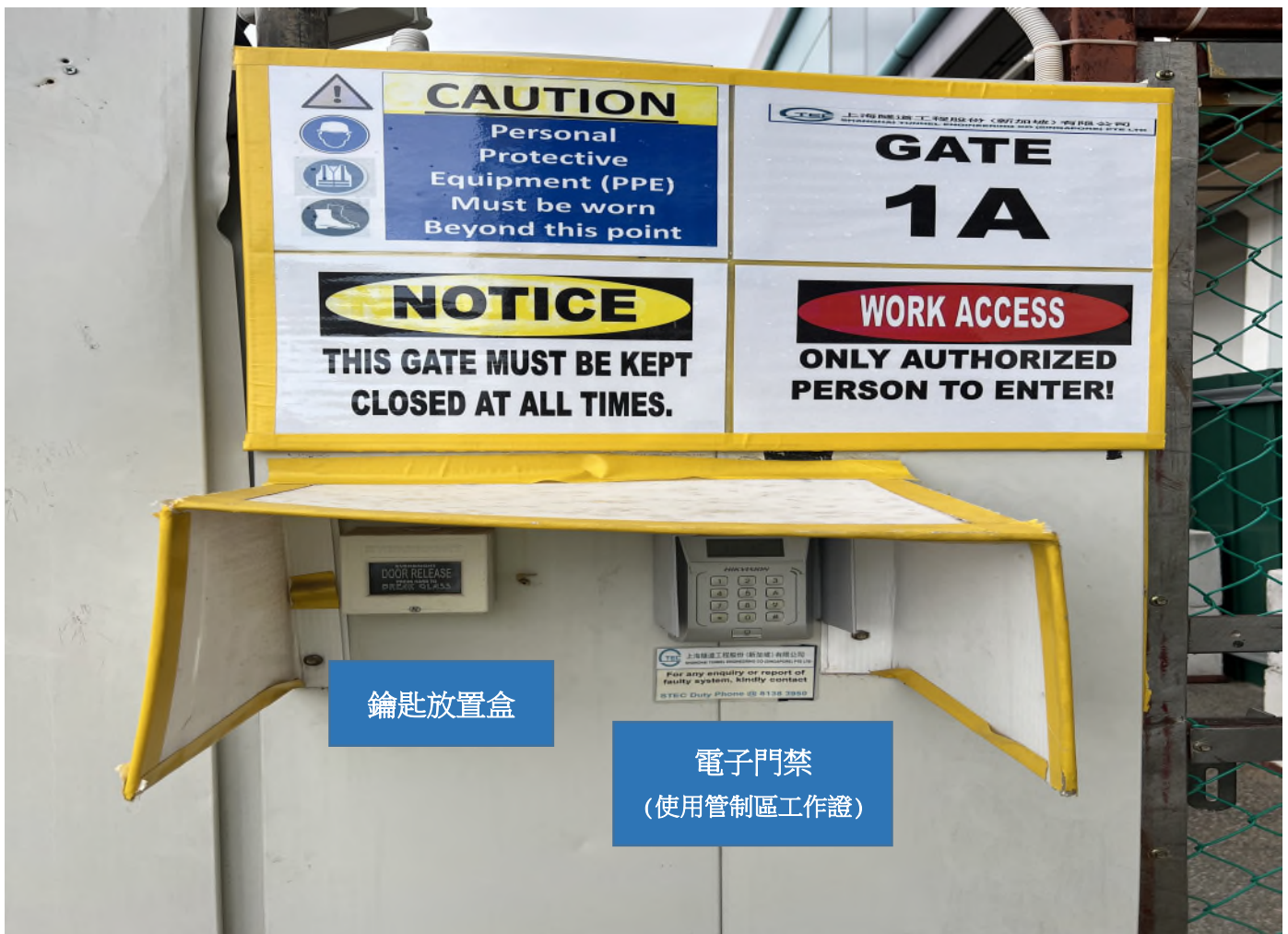
圖 9 工區現場門禁管理
