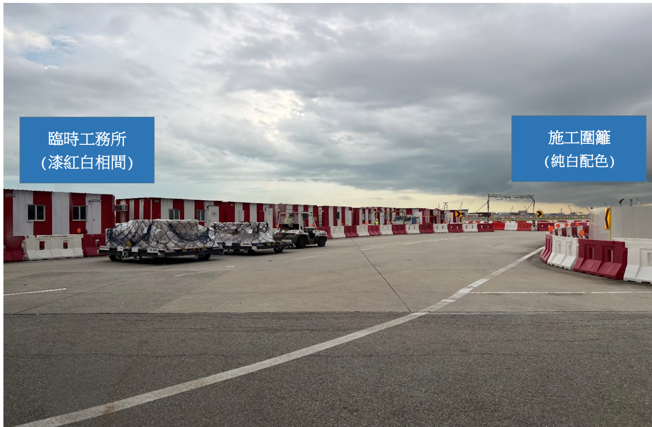
圖 8 現場圍籬、通道與工務所設置
