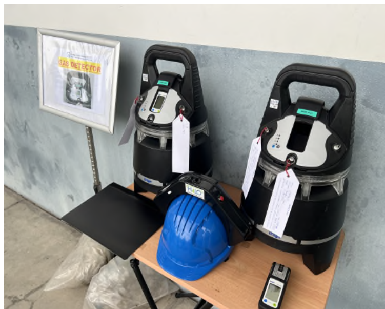
圖 14 可燃氣體偵測裝置及高空車防撞安全裝置
