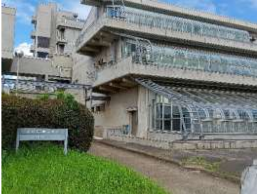
所內土壤大樓
