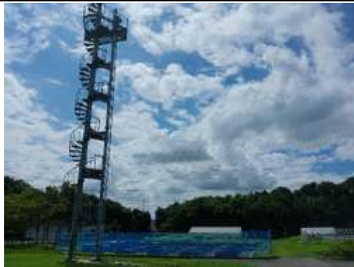
環境研究所內觀測塔
