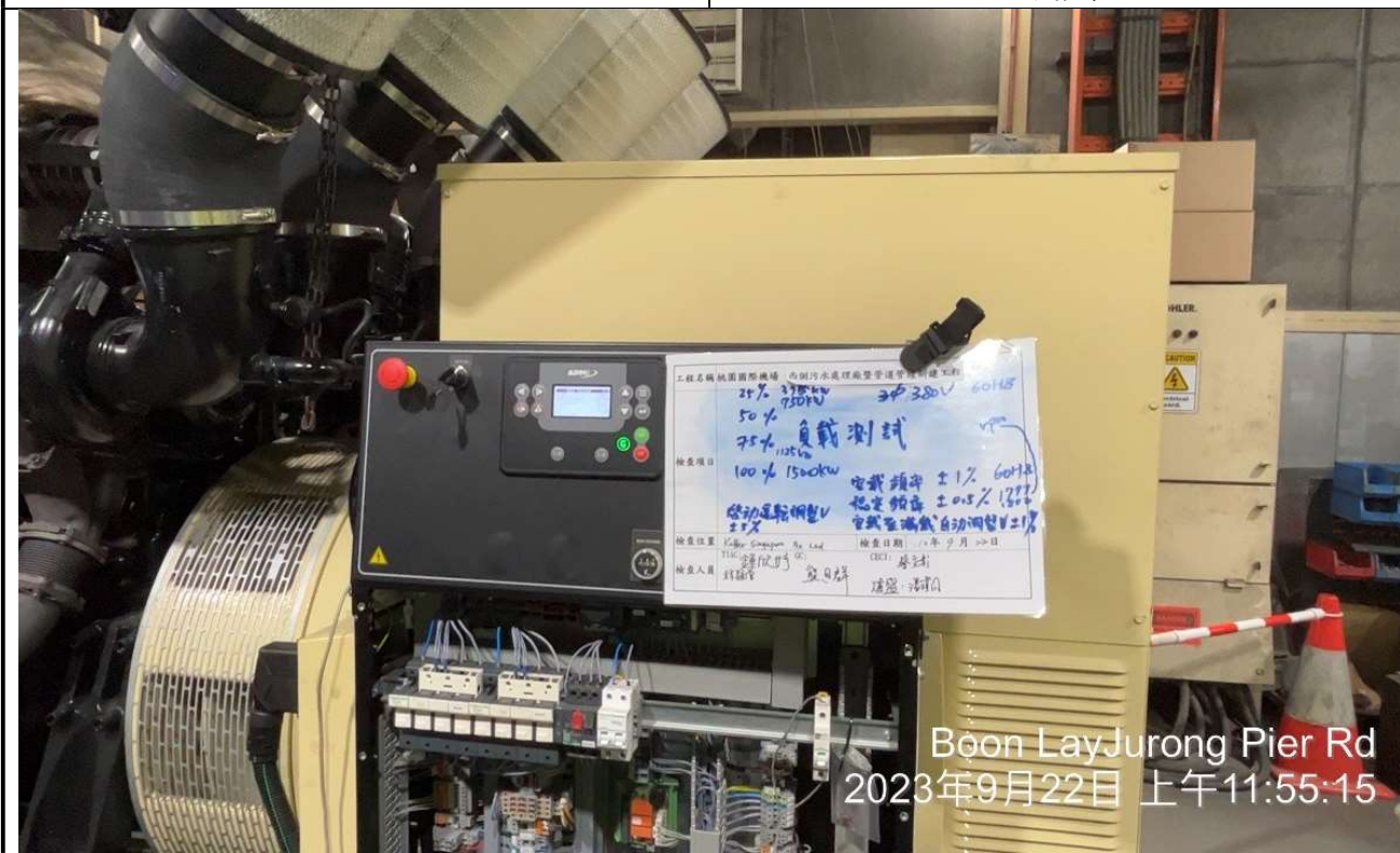
圖 2、柴油引擎負載連續運轉測試
