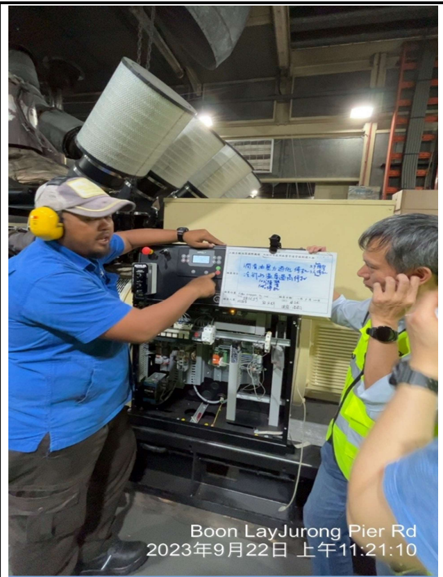
潤滑油壓力過低及冷卻水溫度過高緊報/停機測試
