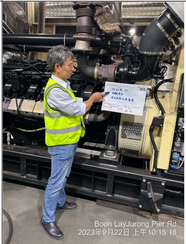
渦輪增壓設備外觀檢查
