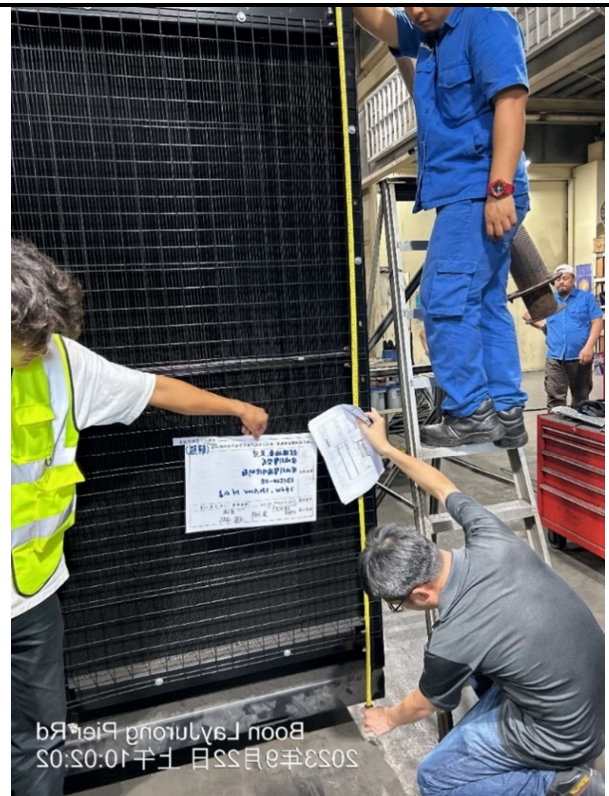
柴油引擎發電機組尺寸檢查(二)
