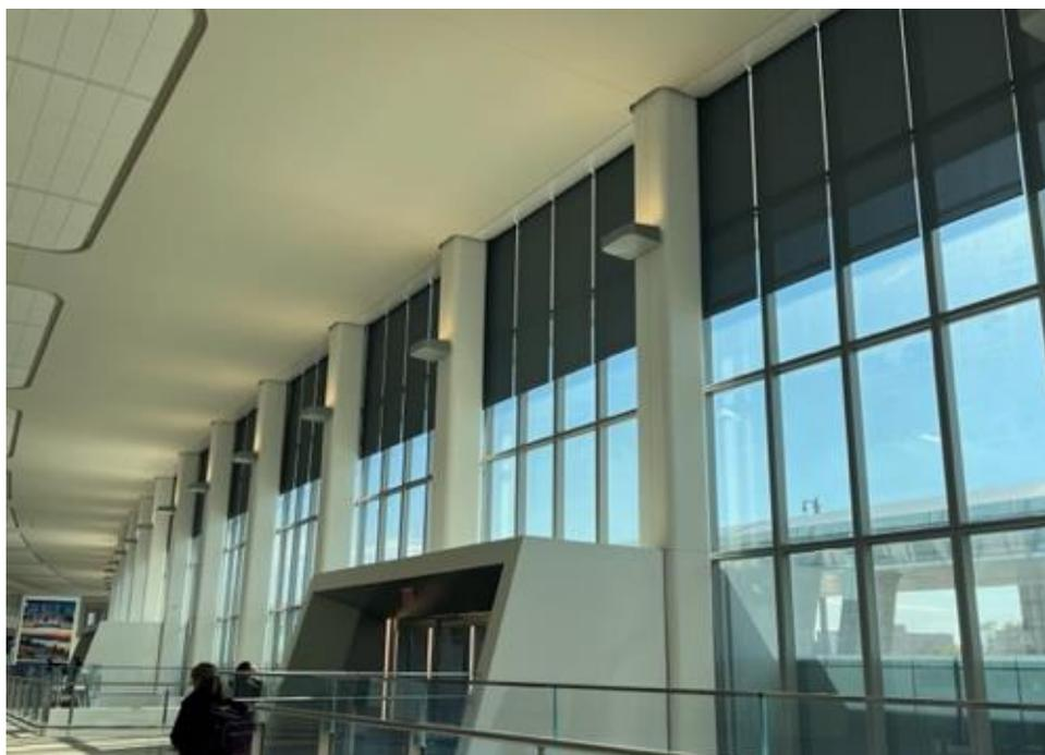
圖 3-69 LGA 新 B 航廈隨光照強度自動調節且下降高度一致
