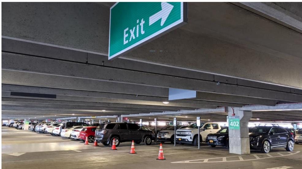
圖 3-61 LGA 新 B 航廈場鑄式梁柱系統之立體停車場
