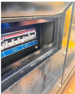
圖 72 檢視車下開關箱無積水
