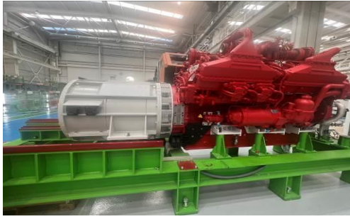
圖 51 引擎與發電機連接安裝
