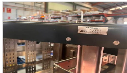
圖 34 CAB 027 配線作業
