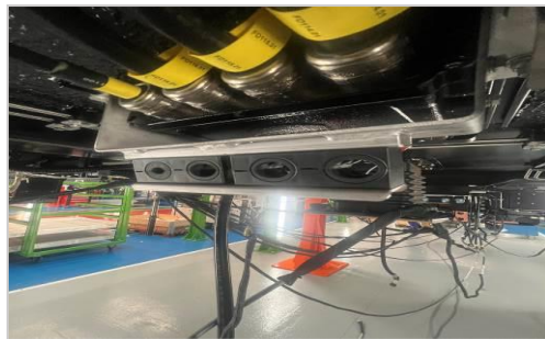
圖 26 車下配線過孔方式檢驗
