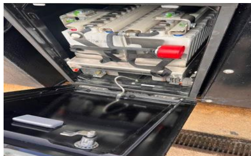
圖 58 檢視車下電瓶箱無積水
