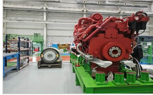
圖 28 引擎、發電機靜態檢驗
