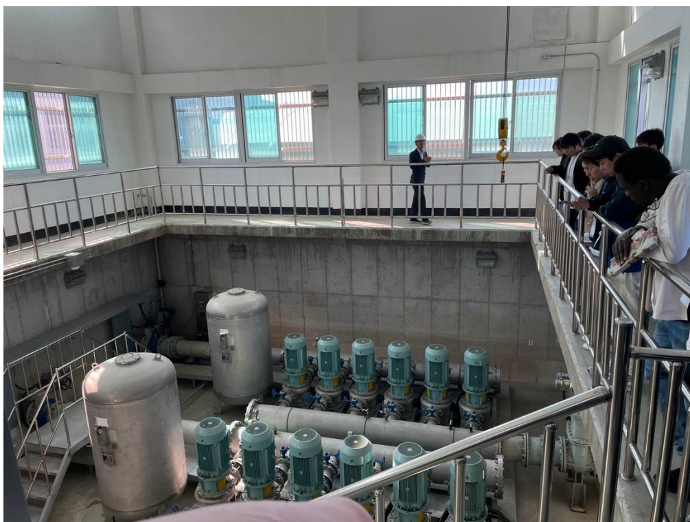
圖11 Clean Water Supply Project Site參觀（加壓站）
