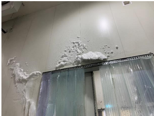
圖26、冷凍庫門上方有結霜情形
