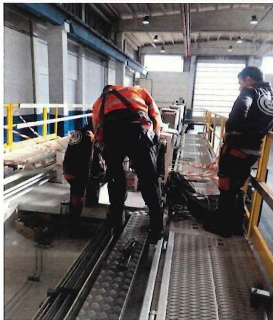
圖 14、CPC-10BW06 第 2 套鑽機井架組裝情形
