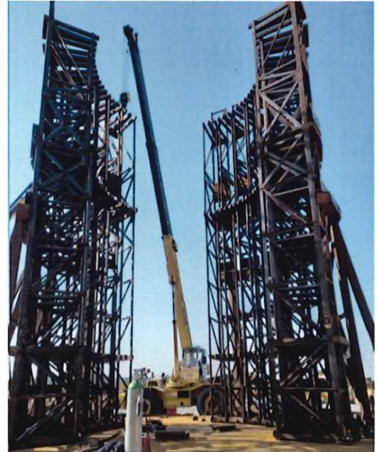
圖 15、CPC-10BW06 管架組裝情形(供應商處)
