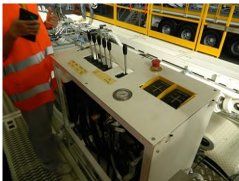
圖 20、車載井架 Rig up 系統經由獨立 HPU 控制，
