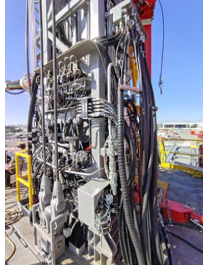
圖 5、HH Series 主井架後方液壓管線錯綜複雜
