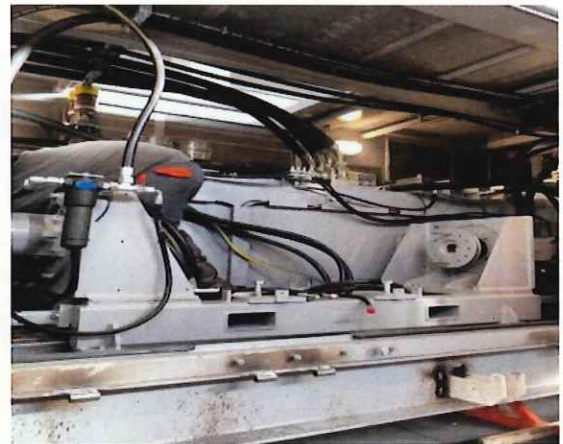
圖 13、CPC-10BW06 液壓動力單元(HPU)組裝情形
