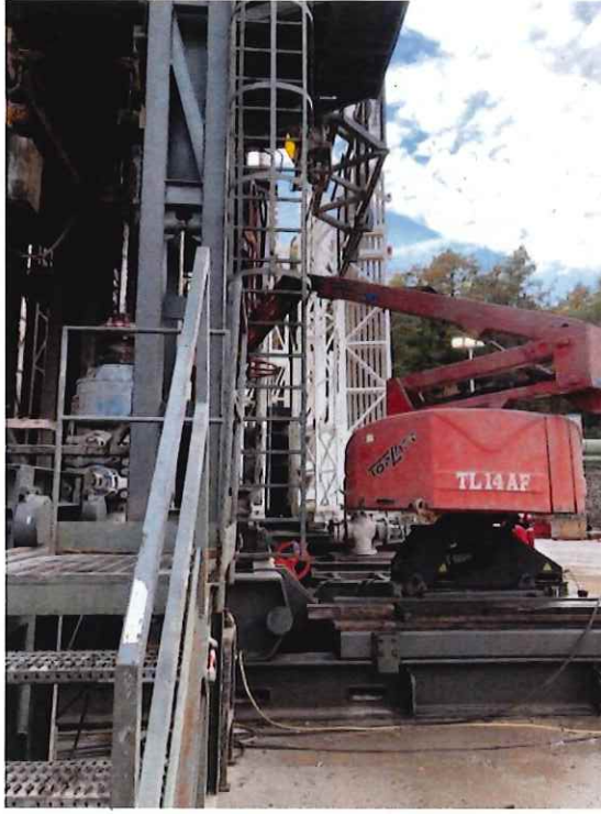
圖 28、高空作業車配置於鑽機底座(1)
