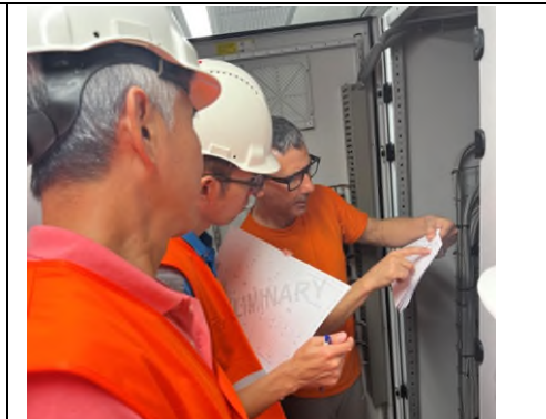
圖 27、以設計圖和實際現場設備，進行控制系統廠驗。
