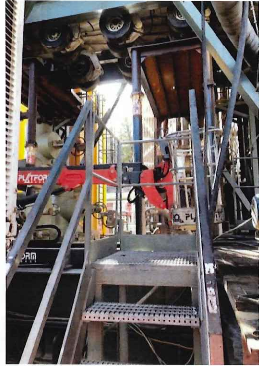
圖 29、高空作業車配置於鑽機底座(2)
