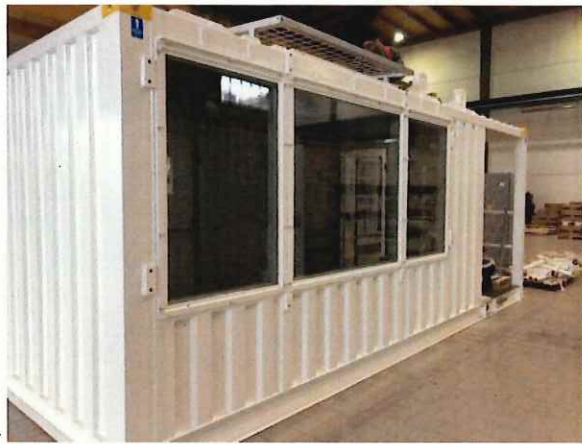
圖 12、CPC-10BW06 第 2 套鑽機操作室組裝情形
