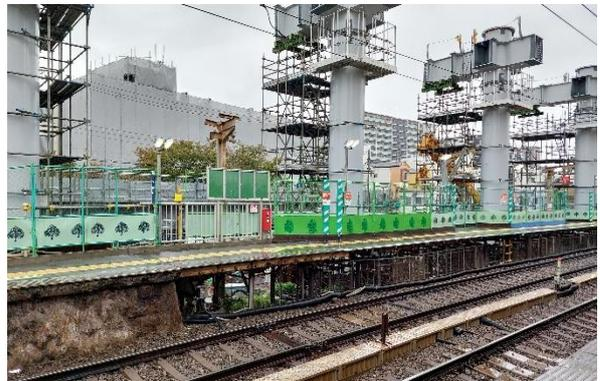
未來高架車站結構緊鄰既有車站，墩柱處臨軌施工作業使既有車站月台更加緊縮。
