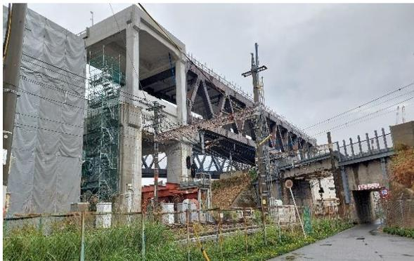
鋼桁架橋以送り出し工法跨越 JR 大阪東線，右側即為 JR 大阪東線鐵路橋梁
