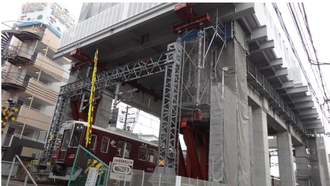
採取直上工法於營運中之線路兩側及上方構築高架鐵路橋
