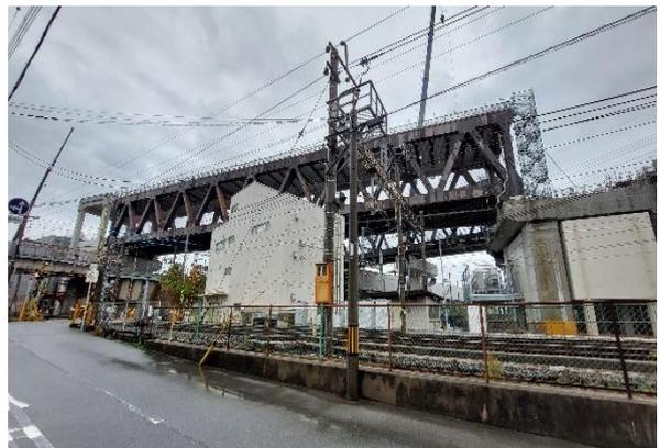
鋼桁架橋以送り出し工法跨越 JR 大阪東線
