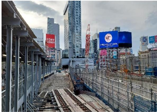
左側為舊有岸壁式月台作為現行旅客轉乘 JR 之臨時通道，軌道切換後軌道工程梁尚未拆除完成。
