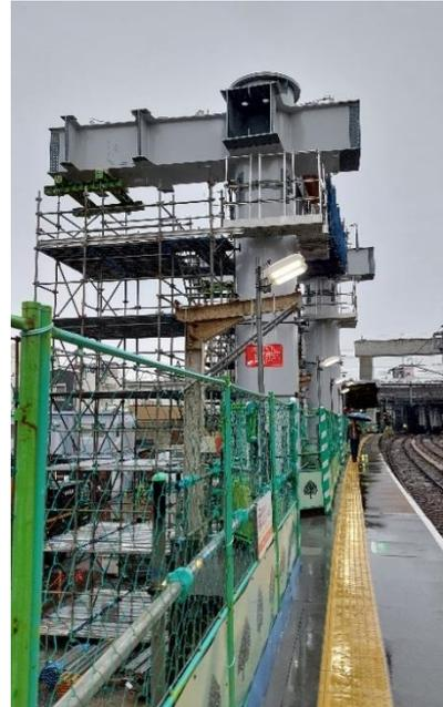
未來高架車站緊鄰下新庄站月台，墩柱處圍籬因考量施工性需更加靠近既有軌，致使既有月台空間更加緊縮。
