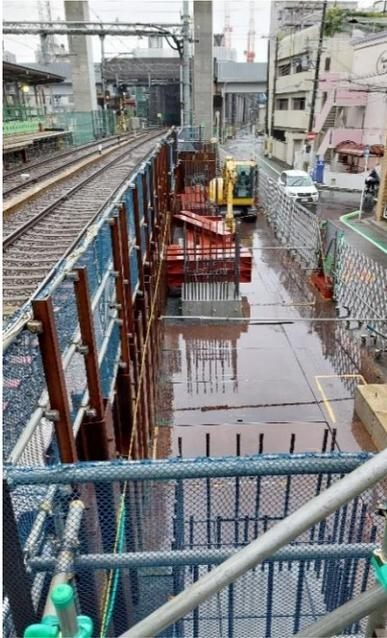
未來永久高架橋墩緊鄰既有車站，以鋼板樁當擋土結構並在上方再架設臨時鋼構圍籬。
