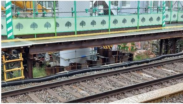
未來高架車站墩柱因緊鄰既有車站，基礎部分施作臨時鋼板樁。
