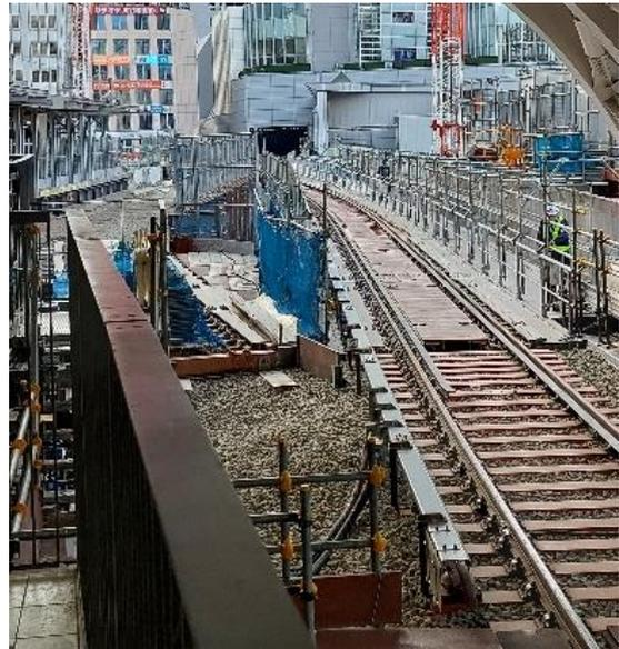
月台右側股道，列車進站後直接進車廠駐車或簡易維修；軌道左側為軌道切換尚未拆除完成之軌道。
