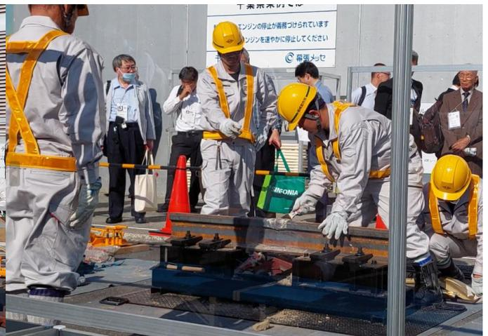
鋁熱劑頭部補修焊接(THR)現場演練過程
