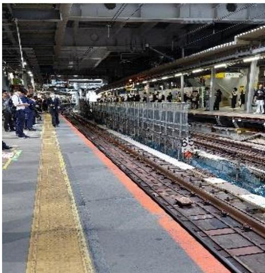
站內現況，因應軌道切換頻率，月台利用鋼構搭建，易配合軌道切換拓寬或內退。
