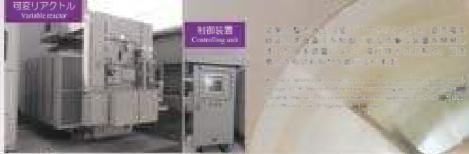
可変リアクトルによる直流電圧制御手法 DC-Power-supply voltage control system using variable reactor
