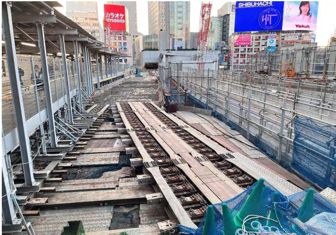
圖 69 澀谷車站三樓銀座線調線增建工程
