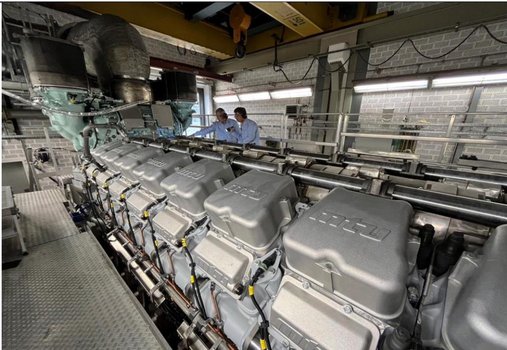
主機運轉測試並檢查油水管路有無震動洩漏情形
