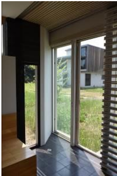
圖 101 LCCM 住宅立面導風牆與通風窗設計
