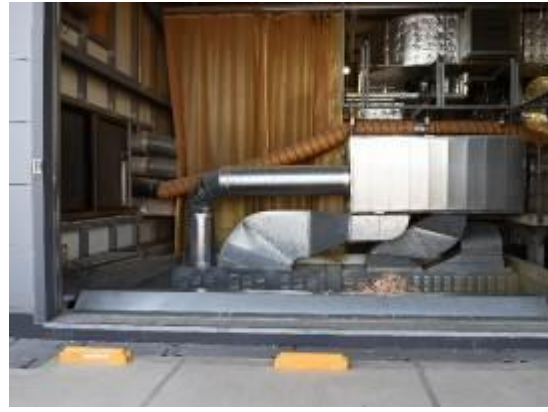
圖 122 生質能進料燃燒系統
