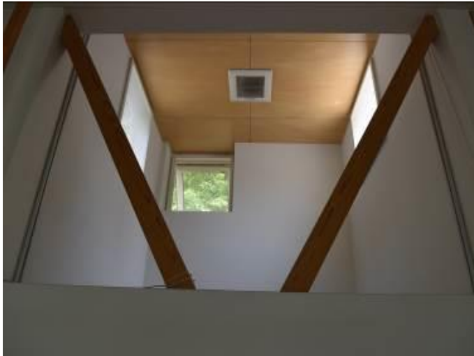
圖 103 LCCM 住宅垂直通風管道設計
