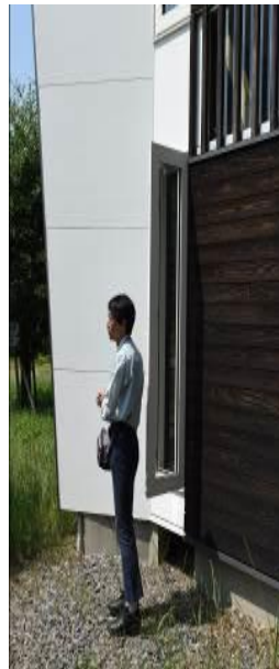
圖 101 LCCM 住宅立面導風牆與通風窗設計
