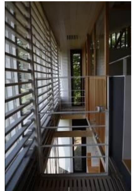
圖 102 LCCM 住宅走廊活動百頁與垂直通風廊道設計
