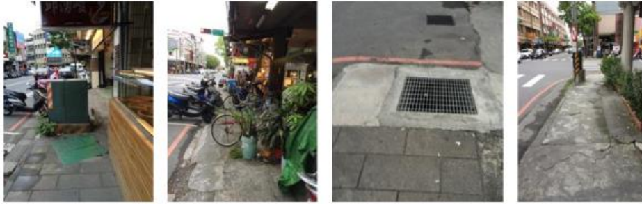
圖 27 臺灣管線及公共設施未整合占用路肩及人行道
