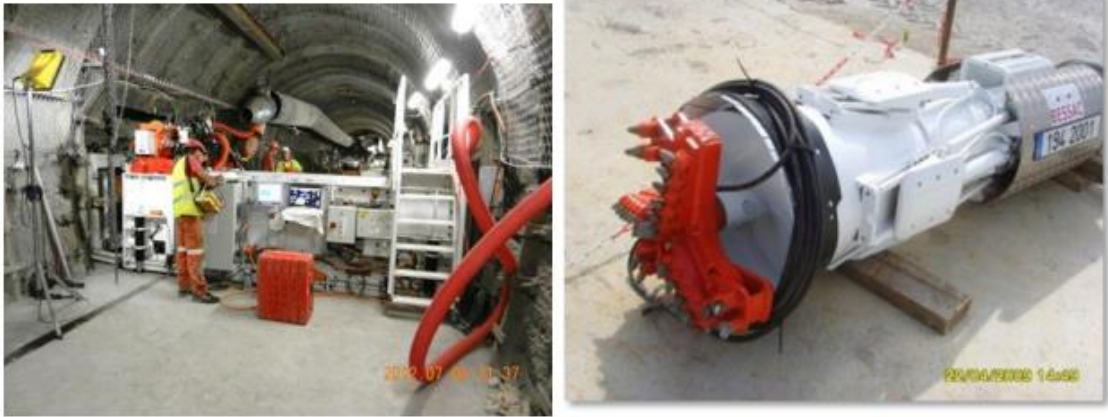
圖 17：處置孔開挖微型鑽機
