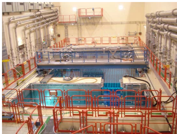
圖 14：KKG 電廠用過燃料濕式貯存設施
