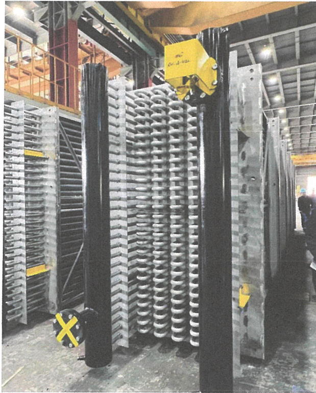
圖(六)再熱端管排組裝完成
