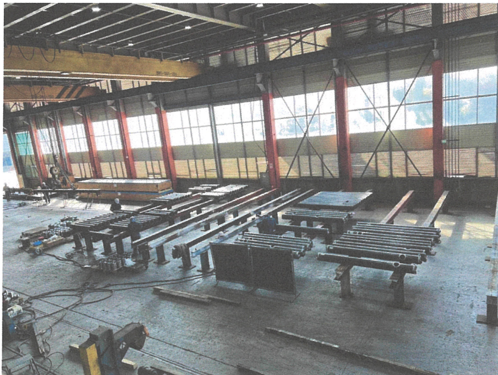
圖(五)MGGH 再熱端管排製造
