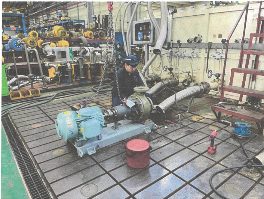
圖(十三)現場師傅安裝測試泵浦
