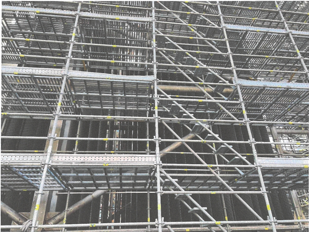
圖(十)中五機現場集塵板安裝
