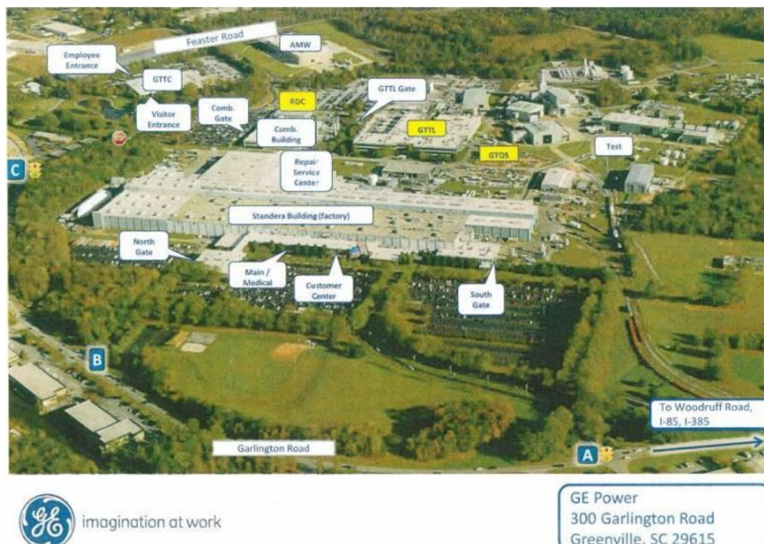
圖 3-1 奇異(GE)公司格林威爾(Greenville)氣渦輪機工廠
