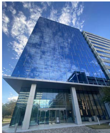
圖 15 Energy II 大樓外觀
