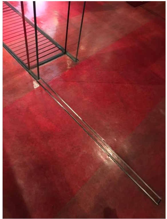
圖 8: 地板與展櫃玻璃軌道接合的設計
