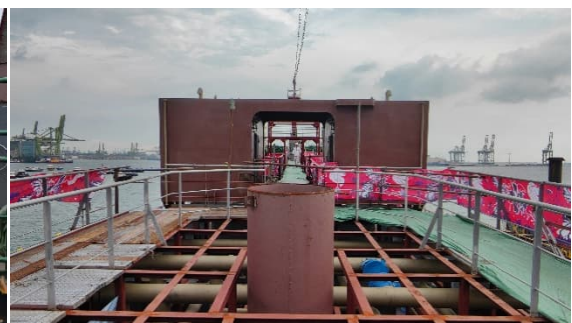
船舫貨油吊桿底座及庫房
