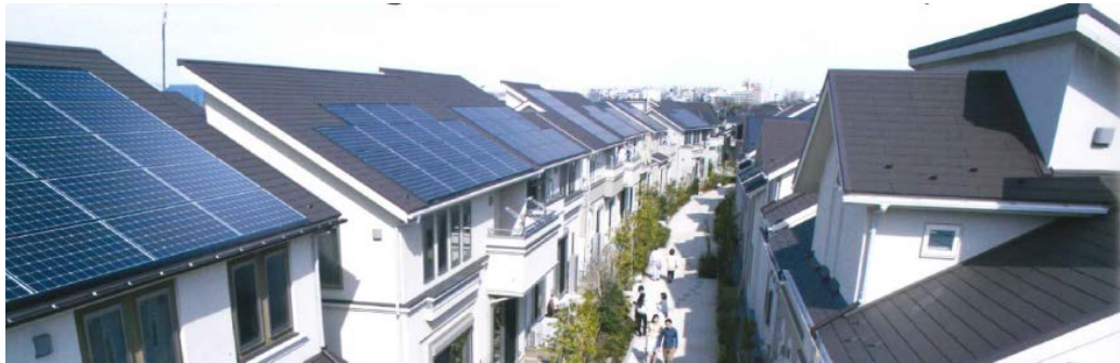
圖 2.7-4 藤澤永續智慧社區之獨棟透天住宅均裝設太陽能光電系統(電力可供自用或出售)
