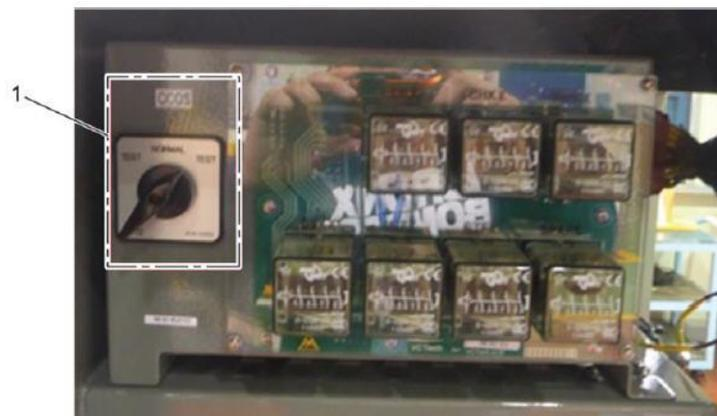
圖3-25 CCOS開關處於“TEST”位置示意圖
